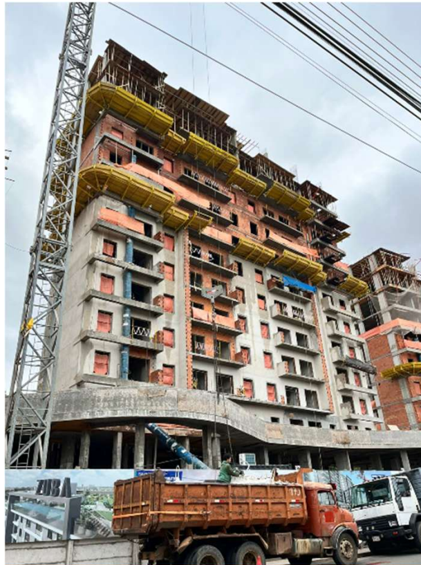
Avance revoque exterior – Avance replanteo de mampostería en N10
